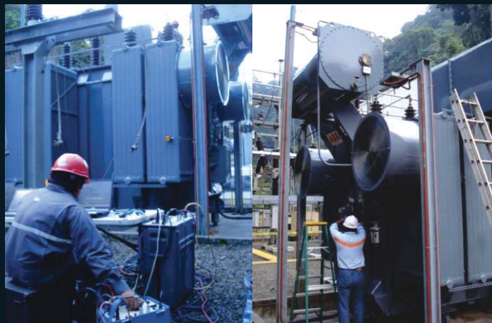
Reparación, instalación y puesta en marcha de transformador de Potencia 20/26 MVA, 69 kV a 13.2/7.6 kV. Hidroeléctrica el Canadá en Guatemala.
